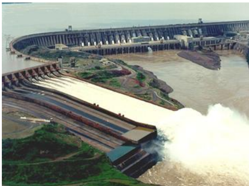
Fig. 4. Usina hidrelétrica de Itaipu [7]
